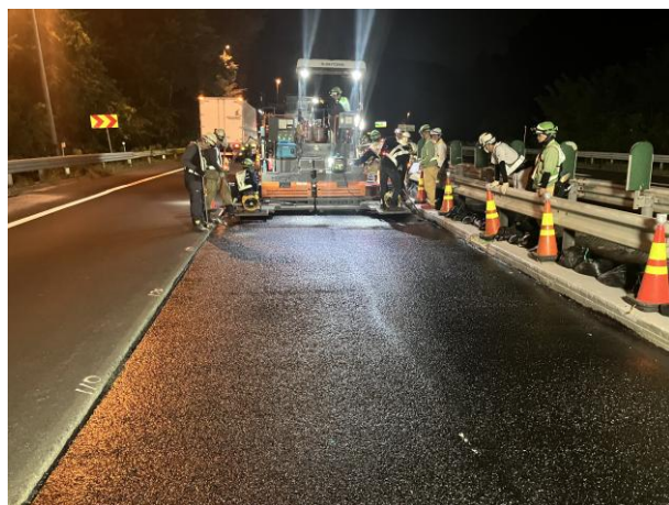
図1 eグース・スーパーの施工状況
