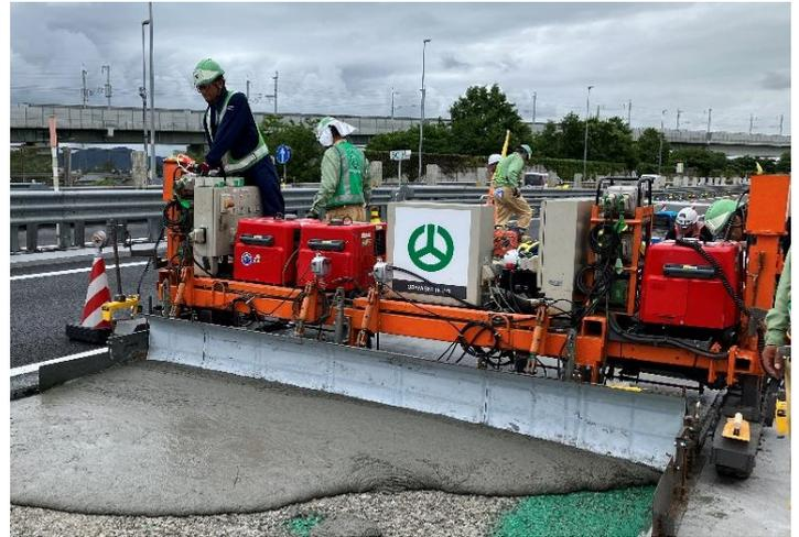
図1 専用フィニッシャによるスティフクリートの敷きならし
