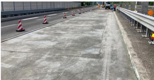
図10 スティフクリート施工後
