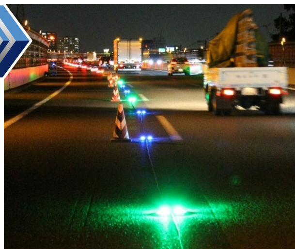
図1 車線規制箇所に設置したミチテラ
