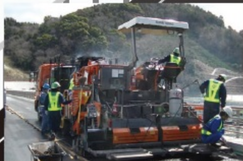
eグースの施工状況
