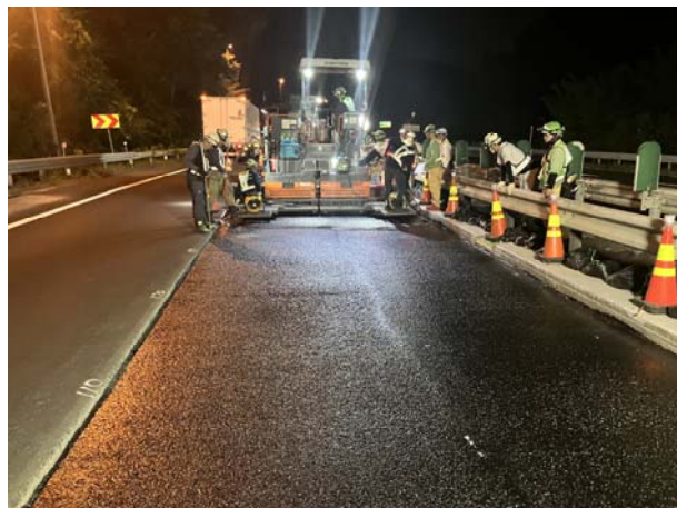
図1 eグース・スーパーの施工状況
