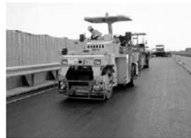
写真-4 二次転圧状況
