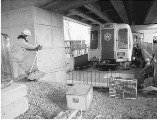
写真-4 障物移動状況（展示車両）
