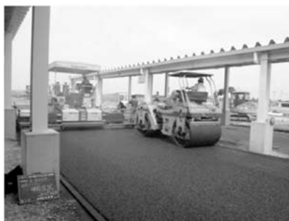
写真-9 母体アスコンの舗設状況
