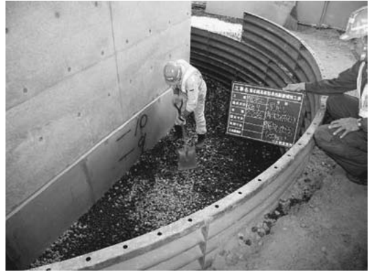
写真-5 振動抑制工法（防振材+単粒砕石）
