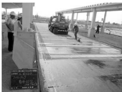
写真-8 タックコート散布状況
