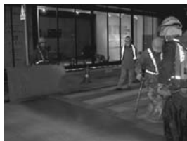
写真-3 下塗りの吹付け
