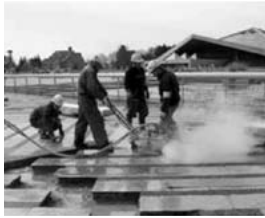
写真-13 透水性 CO の養生・研そ
