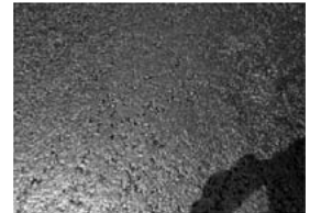
写真-5 二次転圧後の表面
