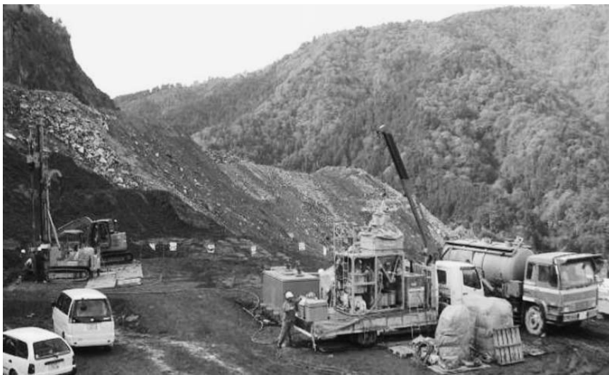
写真-2 施工状況
