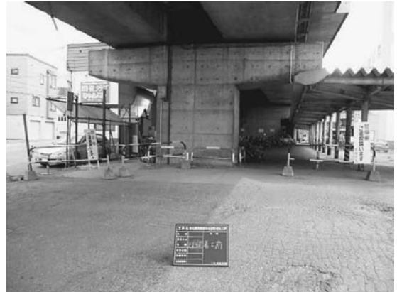
写真-1 着工前（バスセンター横）
