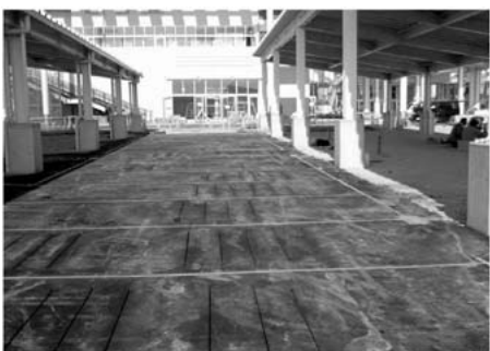
写真-7 通水試験後に入れたカッター溝
