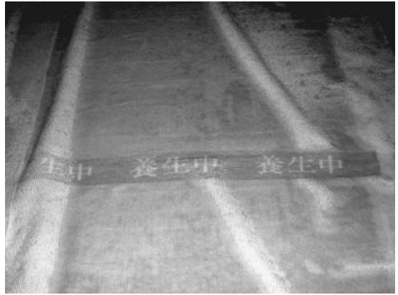
写真-4 吸水変色型養生マット使用状況
