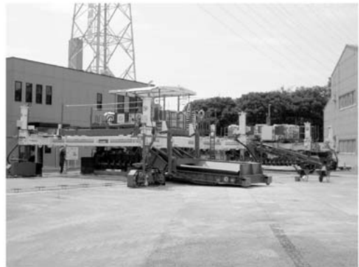
写真-1 サイドフィーダ全景
