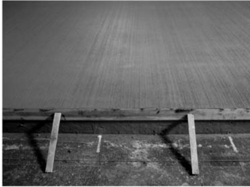
写真-8 補修作業
