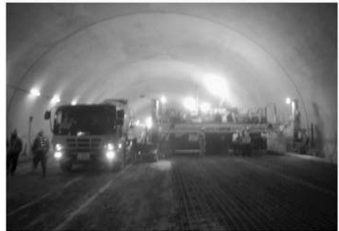
写真-7 サイドフィーダ施工状況
