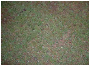
写真-2 樹脂系保護材による緑化舗装路面
