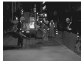
写真-4 硬質骨材の散布
