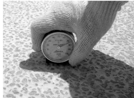
写真-7 ショア硬度計による強度確認状況
