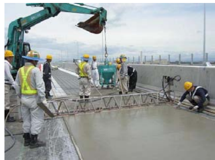
写真-3 SFRC打設状況
