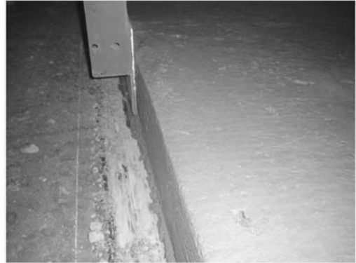
写真-9 機械通過後仕上げ
