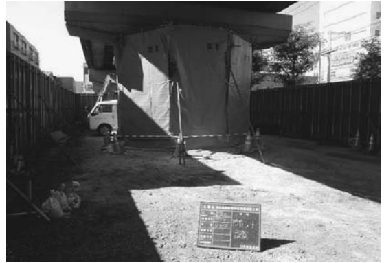
写真-3 防音シート
