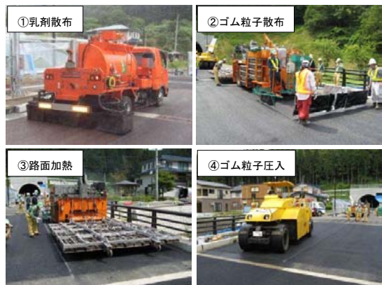
写真-3 ラバーパック E の施工状況
