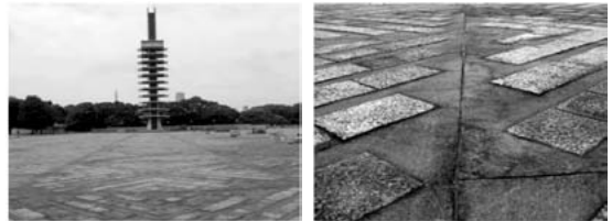
写真-1 中央広場の当該工事前の状況
