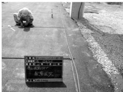
写真-4 点滴パイプの設置状況
