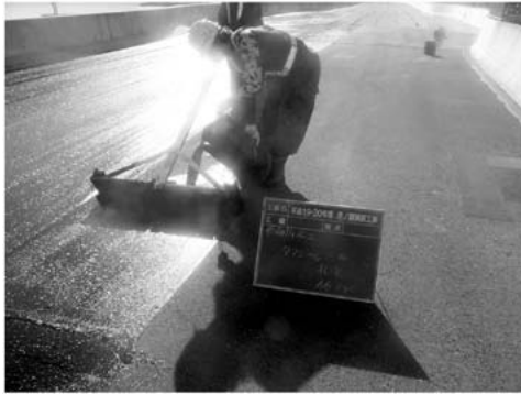
写真-4 塗膜防水の施工状況
