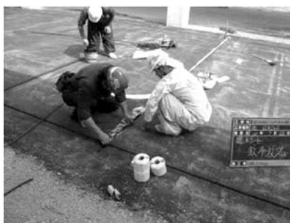
写真-5 導水シートの施工状況
