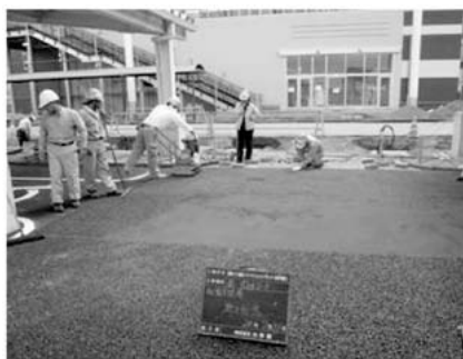
写真-10 細粒材の充填状況
