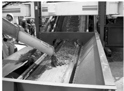
写真-2 横取り用ベルコン
