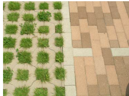
写真-8 熱画像撮影箇所の状況
