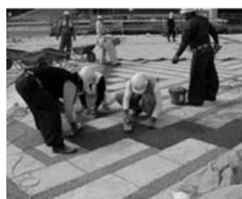
写真-12 透水性COの打設・締固め
