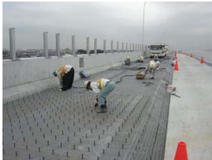
写真-1 スタッド施工状況
