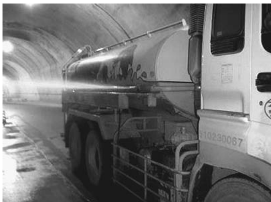
写真-7 側方散水ノズル
