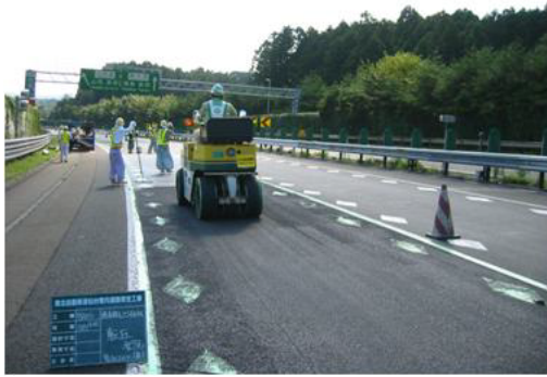
写真.2 PRMS 工法の施工状況
