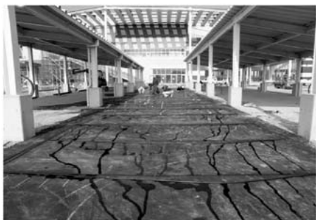
写真-6 通水試験の状況
