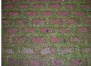
写真-1 ブロック系保護材による緑化舗装路面
