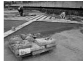
写真-10 石の敷設
