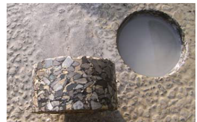
写真—3 コアによる充填状況
