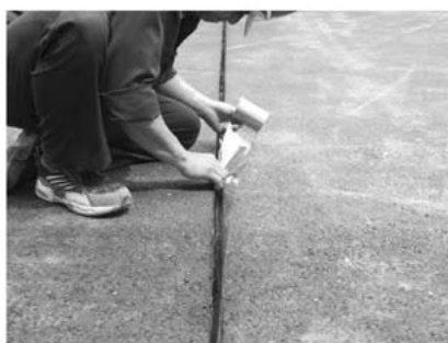
写真-3 配管用溝へのビニールシートの敷設状況
