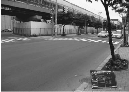
写真-2 パネル型仮囲い
