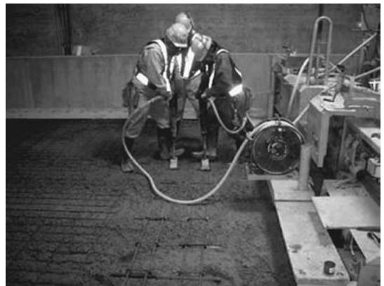
写真-6 バーアセンブリ圧入状況
