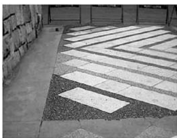
写真-2 試験施工の状況
