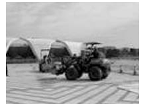
写真-11 透水性COの製造・運搬
