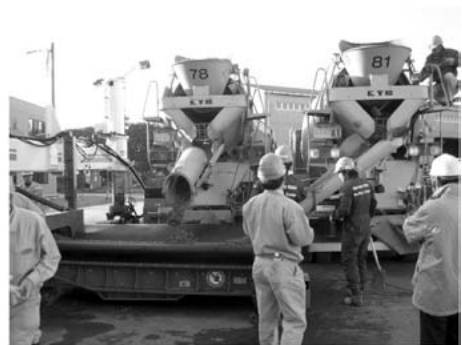
写真-4 2台同時材料供給
