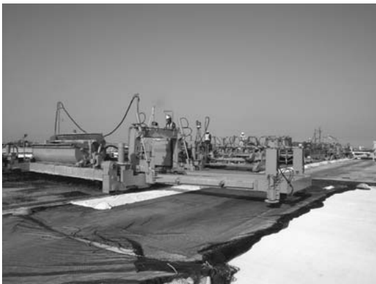
写真-1 コンクリート打設機械配置
