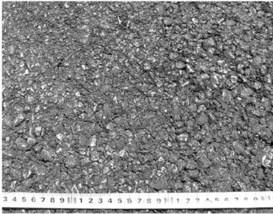
写真-2 既設基層表面
