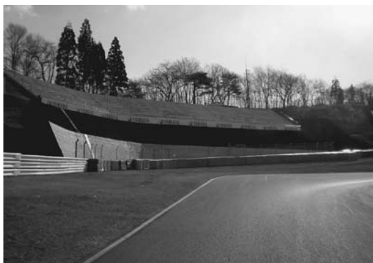
写真-3 第一コーナー完成全景
