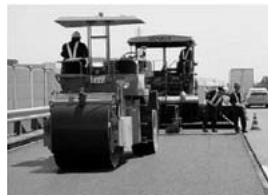
写真-2 初転圧状況
