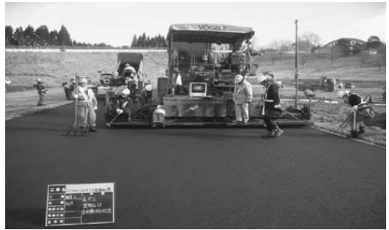
写真-1 施工状況
