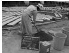
写真-9 モルタル
