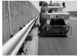
写真-6 端部転圧状況
