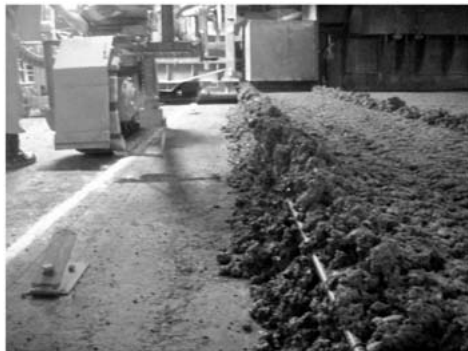
写真-6 機械改良後粗ならし(本施工)
