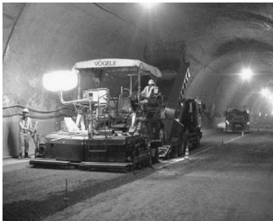
写真-1 ベースペーパーによる施工状況
