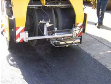
写真-3 転圧状況
