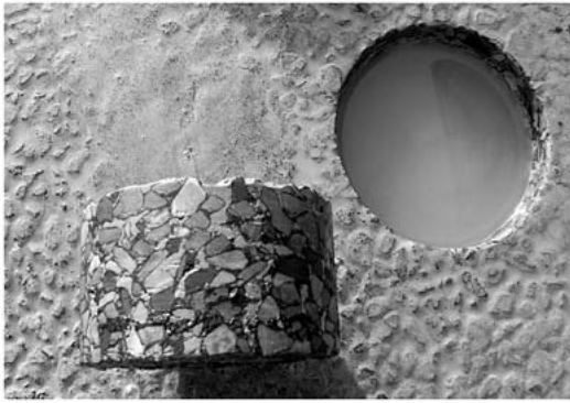
写真-5 コアによる充填状況
