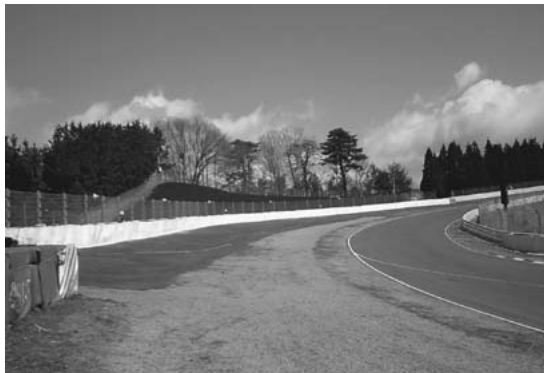
写真-4 最終コーナー完成全景
