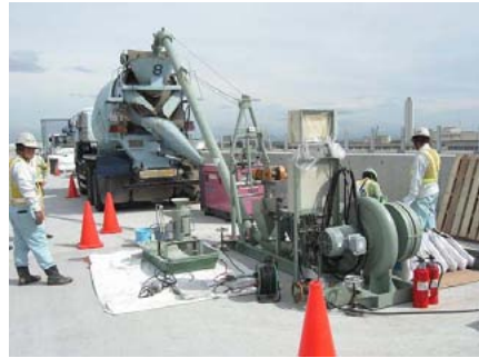
写真-2 鋼繊維現地投入状況
