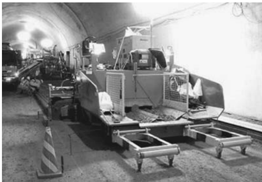
写真-4 改造アスファルトフィニッシャ
