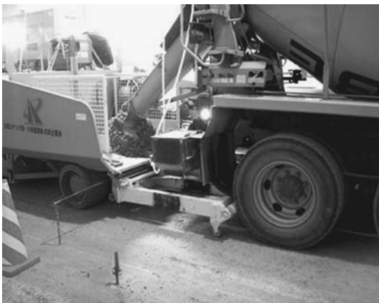
写真-5 生コン投入状況
