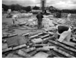
写真-5 既設都電石の撤去
