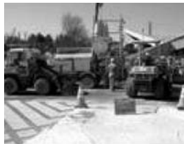
写真-11 透水性COの製造・運搬
