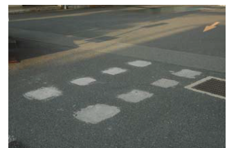
写真 2 構内試験施工箇所供用状況(14 ヶ月後)
