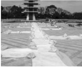
写真-13 透水性 CO の養生・研そ
