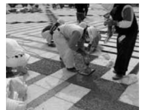
写真-12 透水性COの打設・締固め
