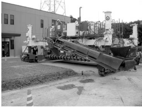
写真-3 スリップフォームペーパーバ全景
