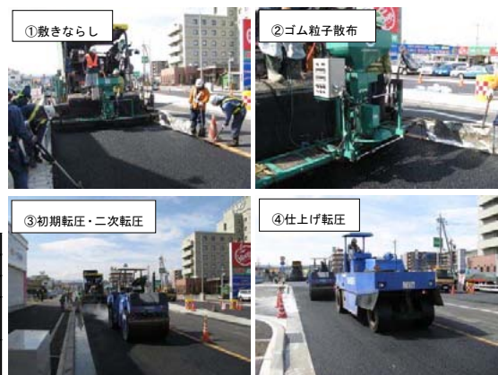
写真-6 ラバーバック Nの施工状況
