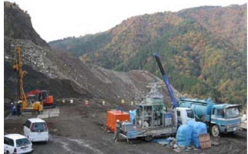
写真-1 施工状況
