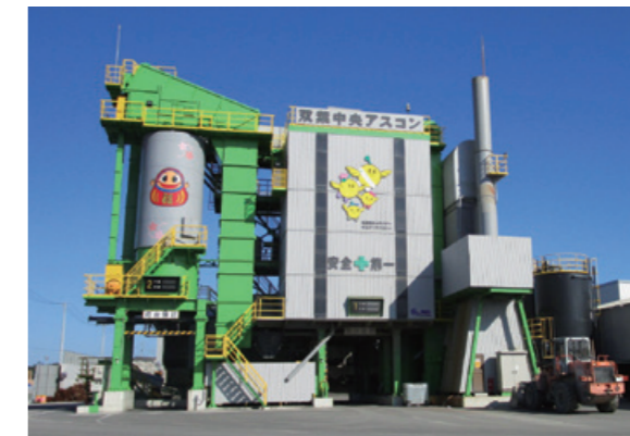
アスファルト合材工場
