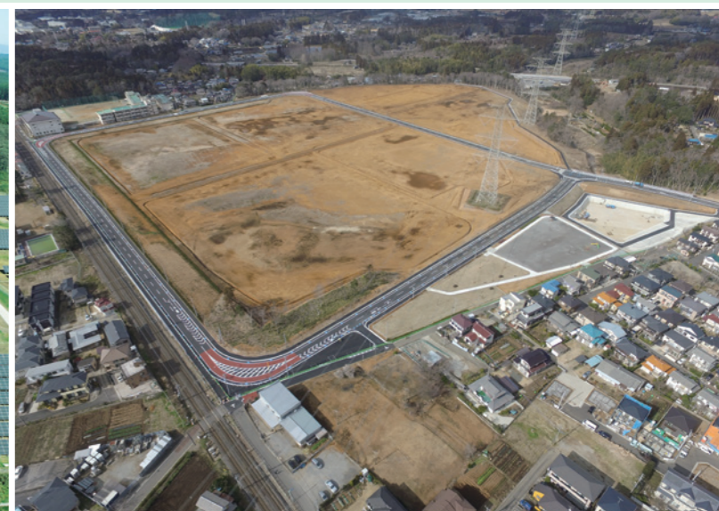
ネクストコア千葉誉田造成工事(千葉市)
