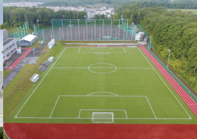
札幌国際大学 総合グランド人工芝工事(札幌市)
