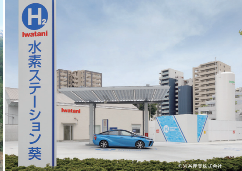
イワタニ水素ステーション 名古屋葵建設工事(名古屋市)
