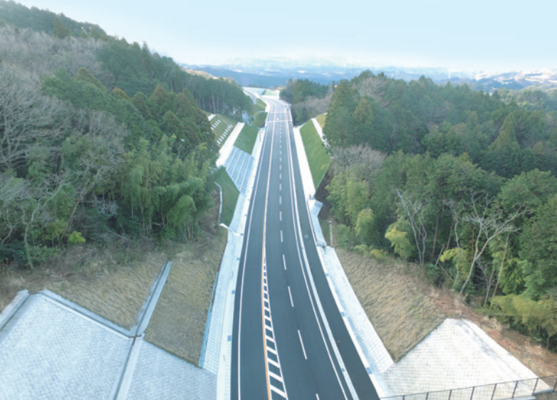
平成30年度 1号笹原山中BP谷田地区舗装工事(静岡県)
