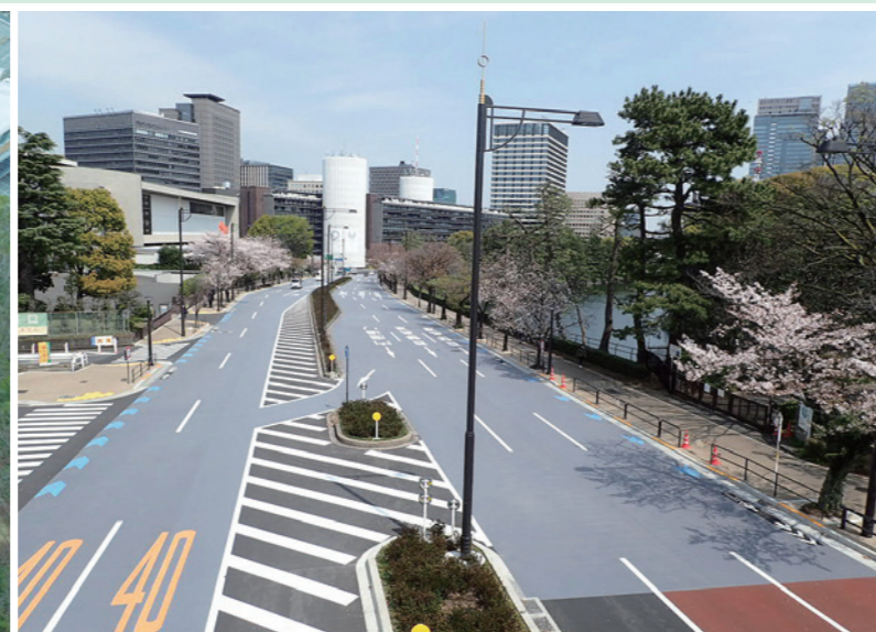
歩道拡幅工事「代官町通り」(第13号)(千代田区)
