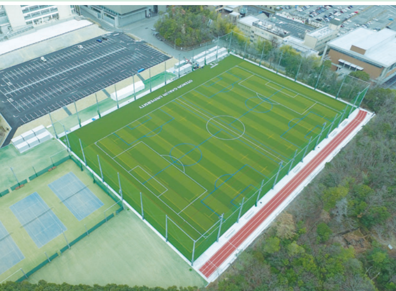
追手門学院安威キャンパス再整備計画のうち舗装(人工芝等)他工事(大阪府)
