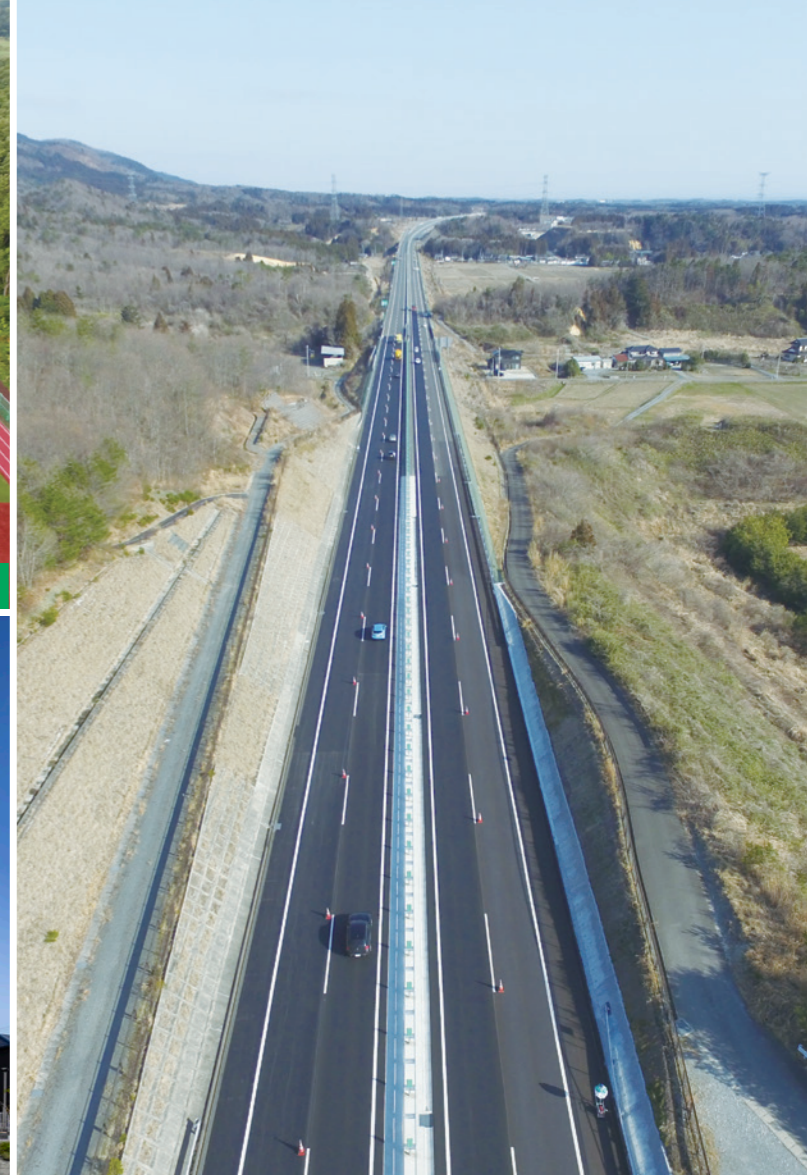
常磐自動車道 相馬工事(福島県)
