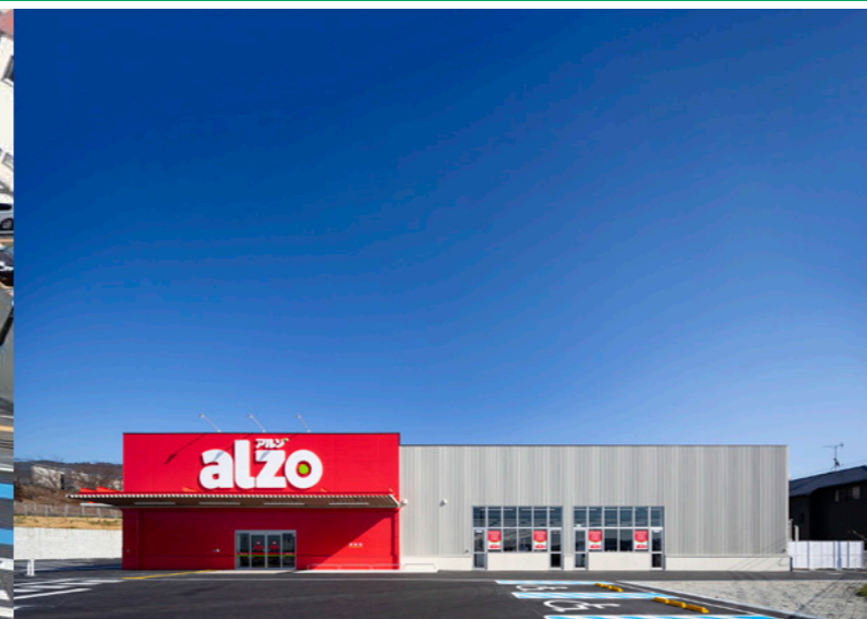
株式会社万惣 アルゾ宇美店 新築工事(福岡県)
