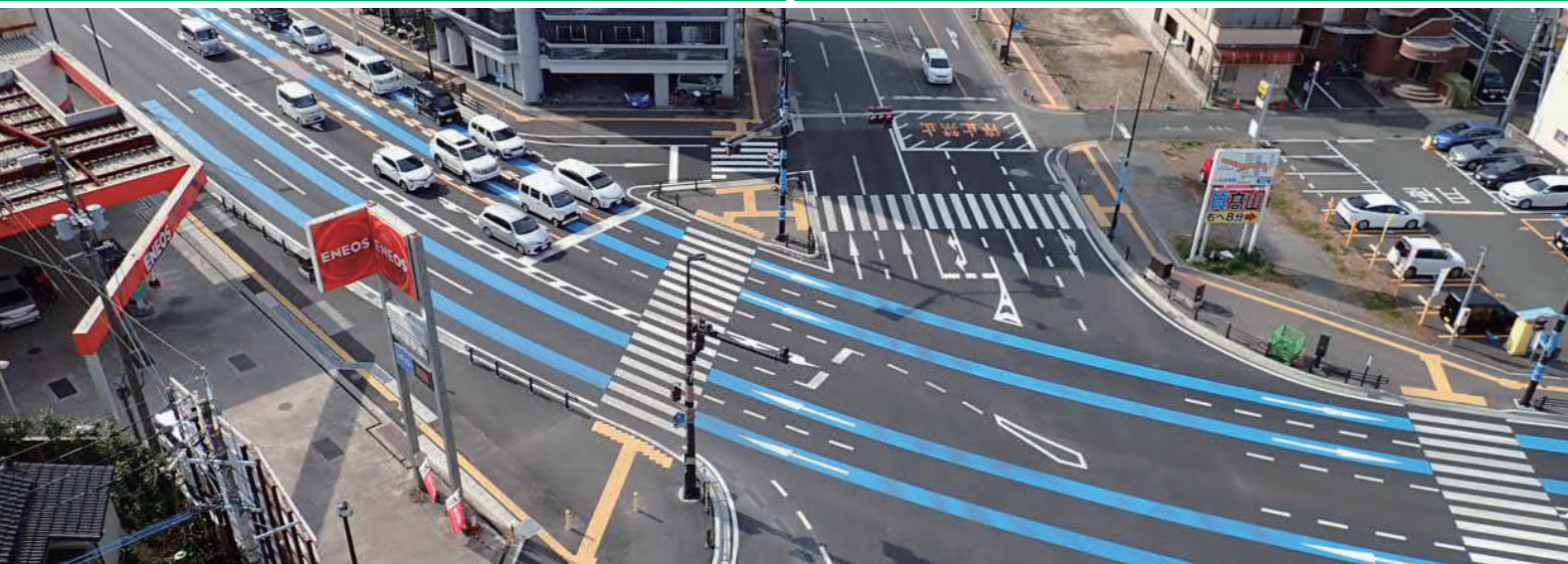
迎町交差点舗装工事(熊本市)
