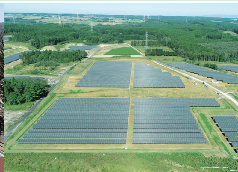
七戸町卒古沢太陽光発電所建設工事(青森県)
