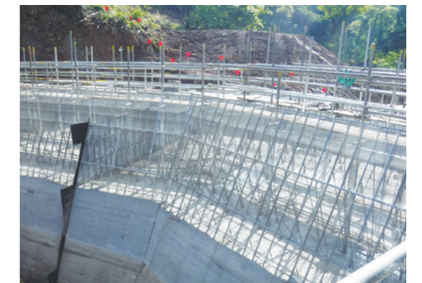
既存の鉄枠を使用することで廃材のほか、重機稼働などに伴うCO 2 排出量も削減
