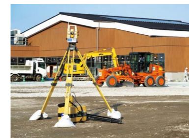
一般社団法人日本道路建設業協会会員企業を対象とした公開施工の様子
