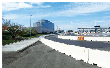
料金所通路拡幅工事 完了状況
