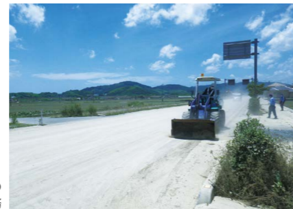
真備町での 災害復旧業務
