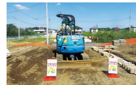
作業現場の安全管理
