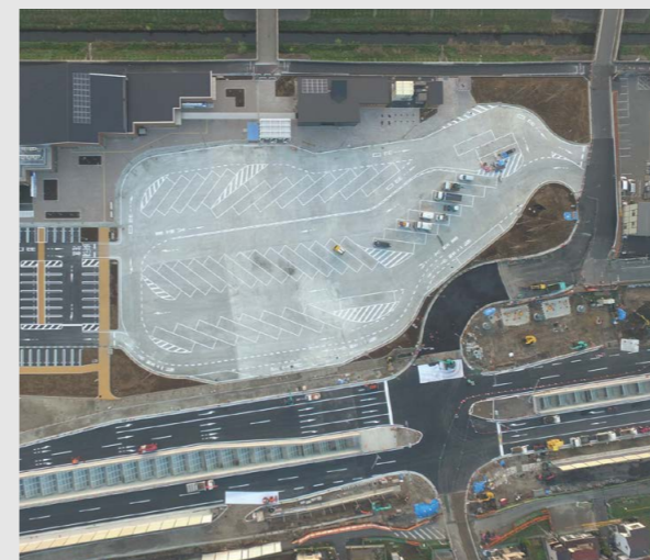
道路休憩施設舗装他工事(千葉県)
