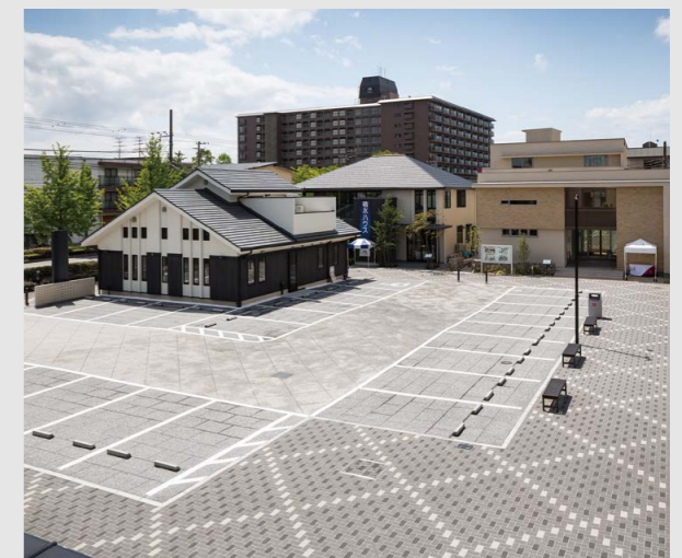
ABCハウジング西宮・酒蔵通り住宅公園 開設工事(兵庫県)
