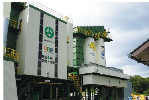
ガス燃料の使用や周辺環境へ配慮した最新鋭の設備を備える東条アスファルト混合所
