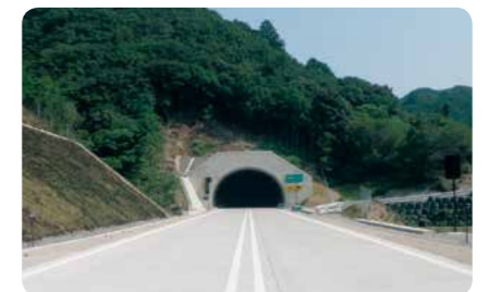
那智勝浦道路市屋第一トンネルコンクリート舗装工事
