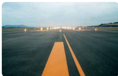
函館空港滑走路(30側)改良工事
