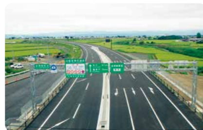
会津若松道路舗装工事
