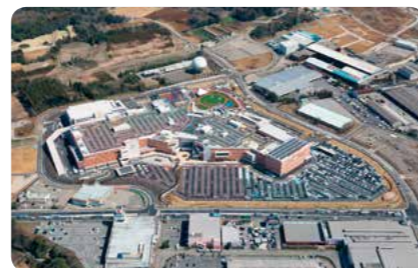
セブンパークアリオ柏 外構工事
