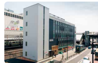
戸塚駅西口駅ビル新築工事
