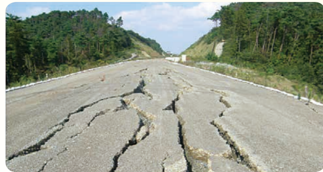
セメント安定処理路盤施工後に震災を受け、ひび割れた着工前の状況
