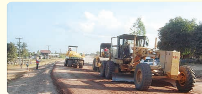
路盤整正状況
