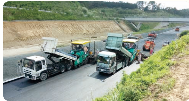
最大で10t ダンプ50台/日、作業員200人/日を要しての舗装状況
