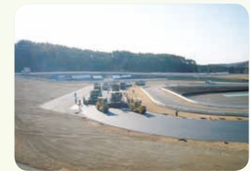
高精度技術が求められるサーキットコースの舗設
