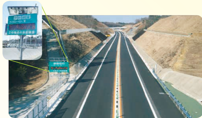
開通直前の状況 (左は路肩に設置された放射線量計)
