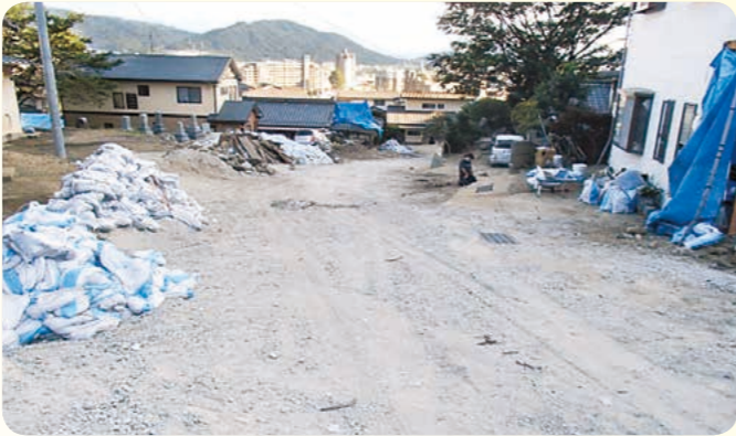
仮設道路完成
