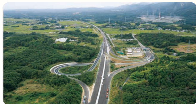
竣工 (常磐富岡IC付近)
