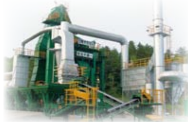
三陸アスコン 岩手県下閉伊郡田野畑村 2013年5月操業
