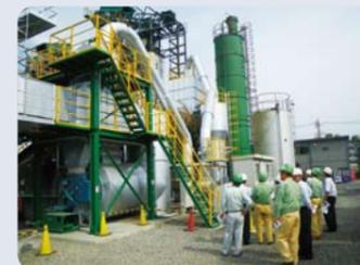
設置完了した脱臭炉
