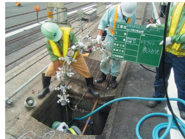
災害により破損した多くの雨水排水管。非開削で施工できる当社の「管更生工法（シームレスシステム工法）」は、施工範囲が小さく、施工時間が速いという特性から最適な工法として評価され、復旧工事に採用された。元請からの工事の受注・施工には当社の子会社・東洋パイプノベートがあたった。
