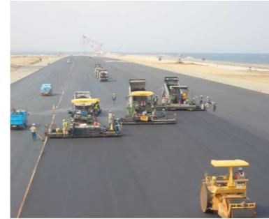
滑走路表層 舗装3工区での共同施工 滑走路の表層はアスファルトプラントの出荷能力の有効活用と、施工ジョイントを最小限にする目的で、舗装第3工区での共同施工
