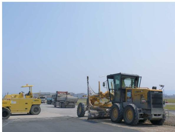
mmGSP搭載グレーダーによる路盤整正
