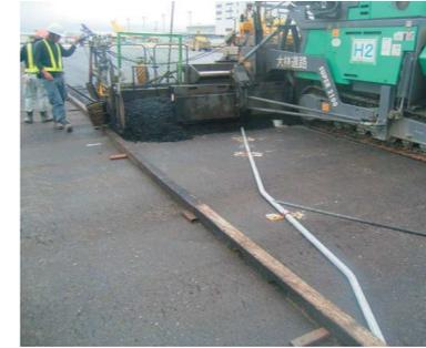
灯火一体施工 従来工法はアスファルトプラント安定処理施工後にカッティングを行いグースアスファルトを注入するが、砕石セメント安定処理後投下基台配置と配管をし安定処理を行った
