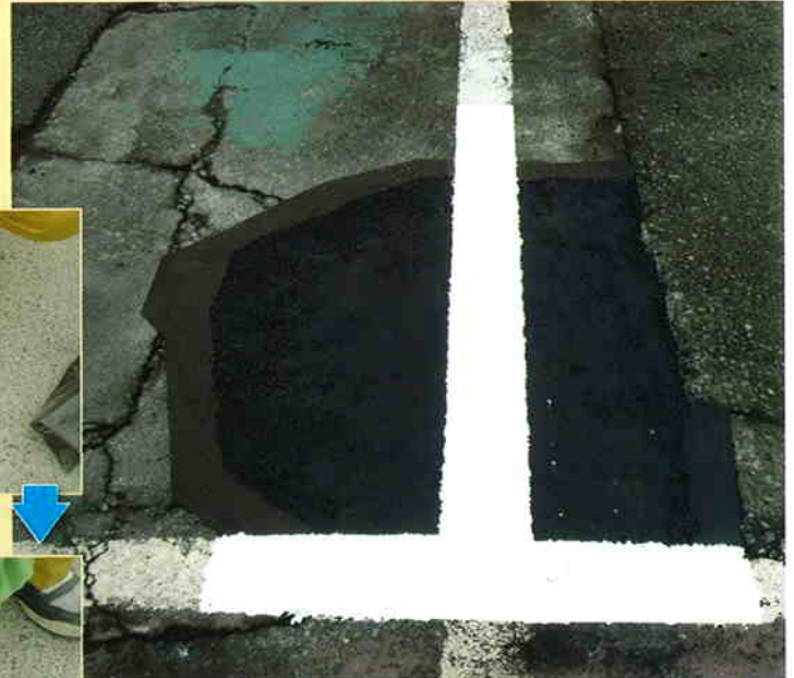
アスファルト舗装の補修
