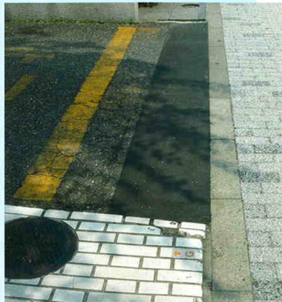
出入り口の段差修正
