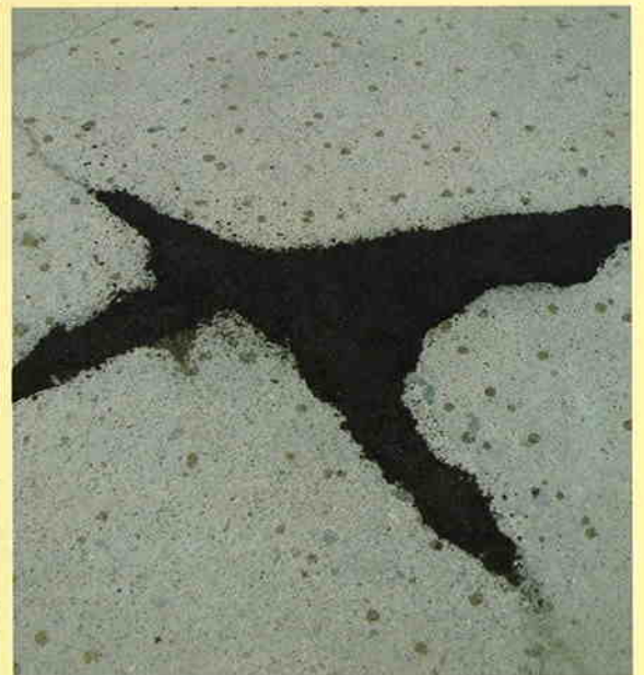
コンクリート舗装の補修
