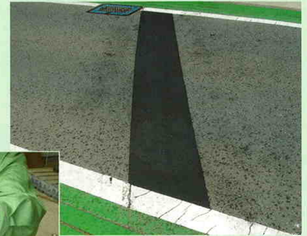
車道の段差修正
