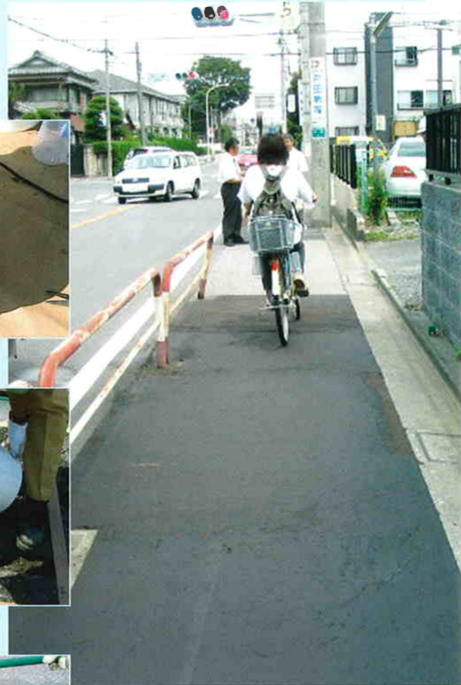
歩道路面のリフレッシュ
