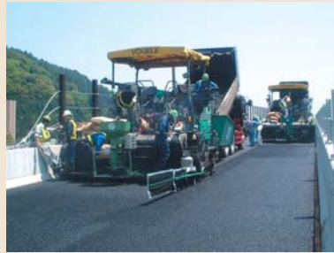
ゴムチップスプレッダを用いた施工状況
