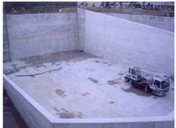
写真－７ 内部完成写真
