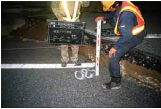
写真-2 発災直後の橋梁・BOX段差部
