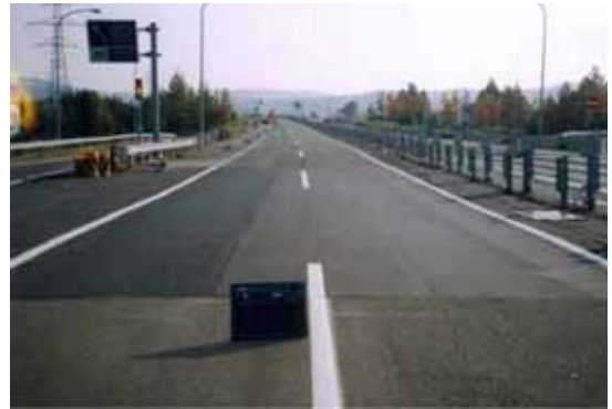
写真-5 第三段階における段差摺付状況
