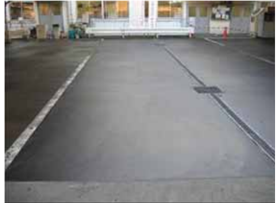
写真-11 駐車場における表面処理
