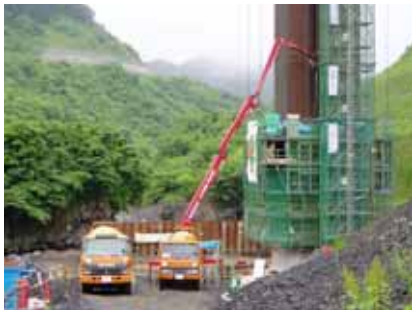
写真-8 リフト施工 (コンクリート打設)
