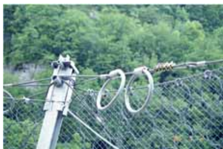
写真-11 ダブルブレーキリング
