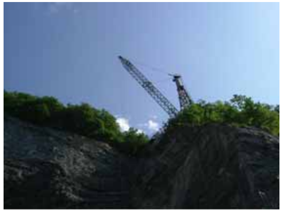
写真-3 常設のタワークレーン
