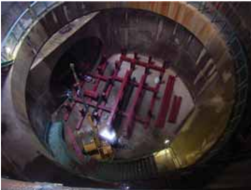
写真-1 到達受構台設置状況
