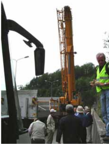
写真-7 現場へ運んでくれたクレーン
