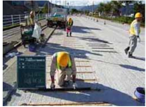
写真-1 フラットバーステッチ施工状況
