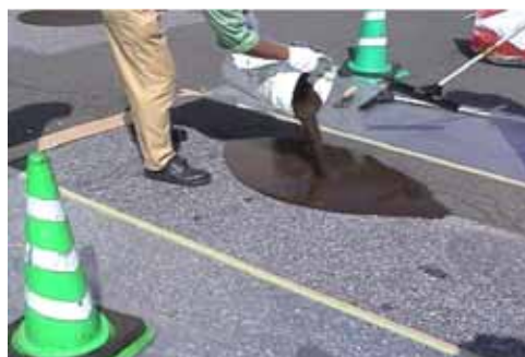
写真-7 混合物排出状況
