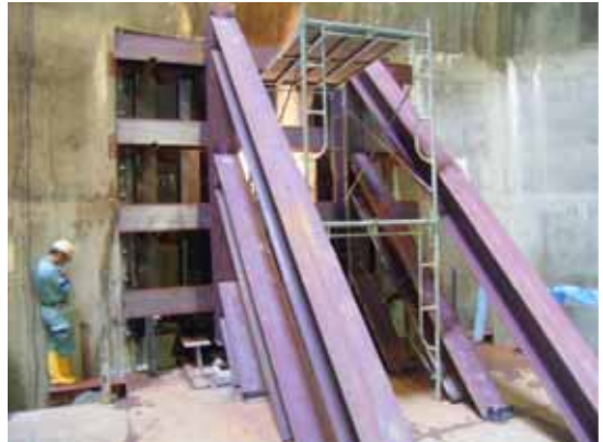
写真-3 閉塞鋼板設置
