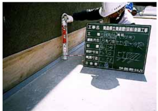
写真-6 版築壁養生状況
