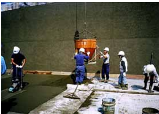
写真-3 荷下ろし状況
