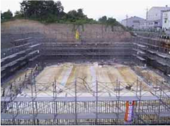
写真－４ 底版養生状況図
