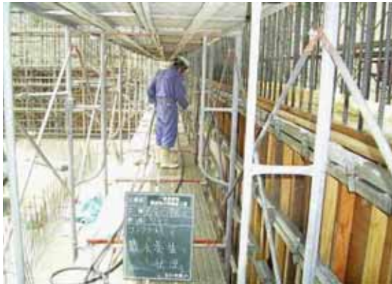
写真－５ 散水養生状況
