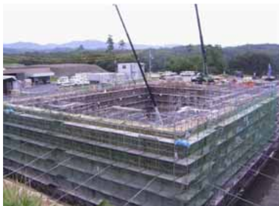
写真-1 鉄筋組立・型枠組立状況
