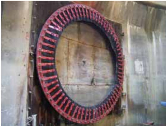
写真-4 到達金物設置
