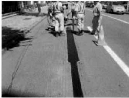
写真-8 施工状況①
