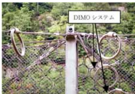
写真-10 DIMOシステム設置状況
