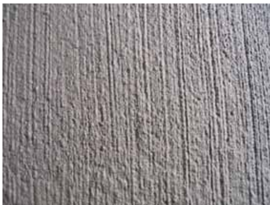
写真-2 ほうき目仕上げ
