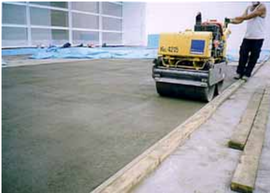
写真－8 転圧状況
