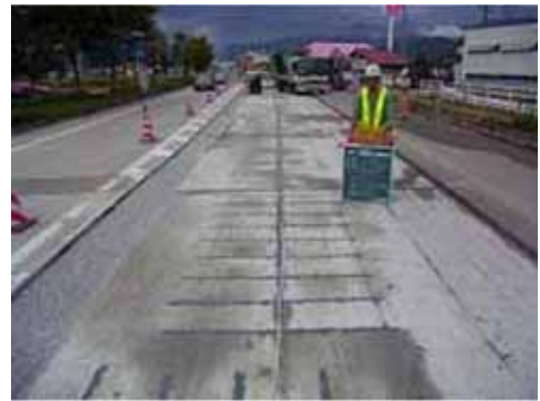
写真-2 フラットバーステッチ完了
