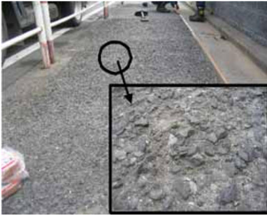
写真-8 施工前状況
