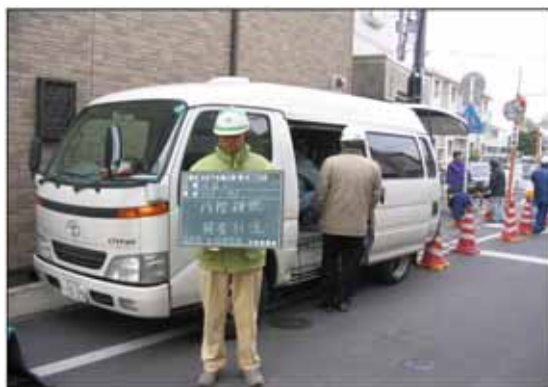
写真-4 TVカメラ検査状況
