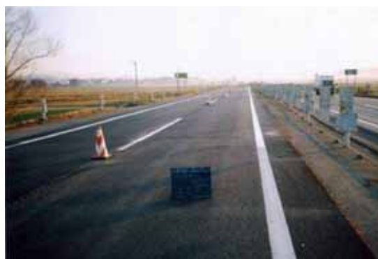
写真－7 第四段階の施工完了状況
