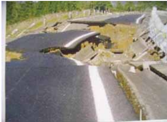
写真-1 関越自動車道の被災状況
