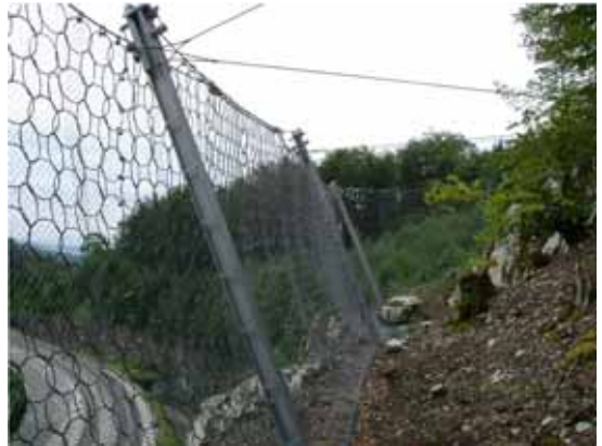
写真-8 RXI-050設置状況
