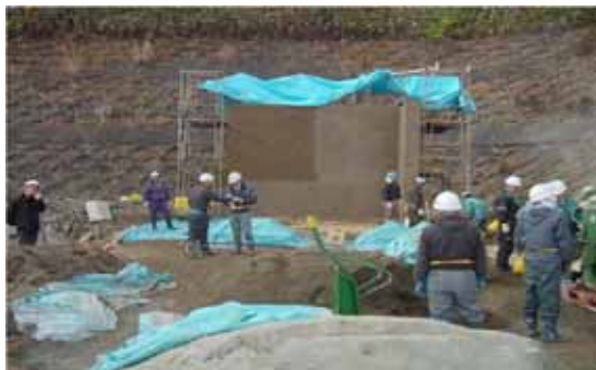
写真-1 施工状況
