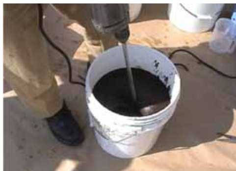
写真-6 混合状況
