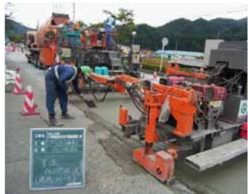
写真-3 打設状況
