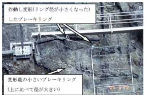
写真-6 ブレーキリング作動状況
