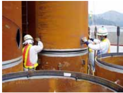
写真-3 鋼管建込み
