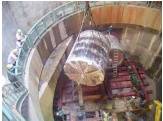
写真-6 掘進機回収状況
