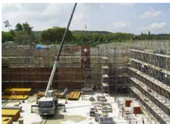
写真-2 内部組立状況
