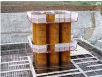
写真-2 1段目鋼管
