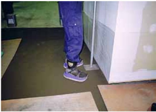
写真－7 壁際締め固め状況
