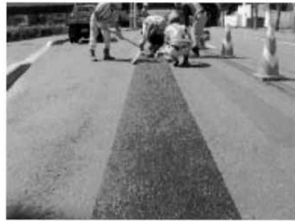
写真-9 施工状況②
