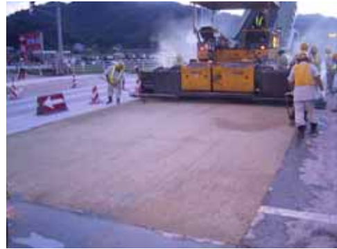
写真-5 舗設状況
