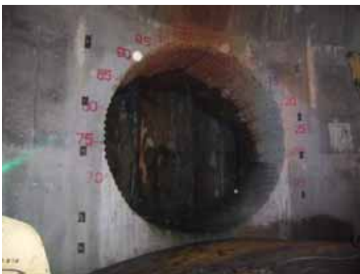
写真-2 到達壁開口 (φ3400×L3100)
