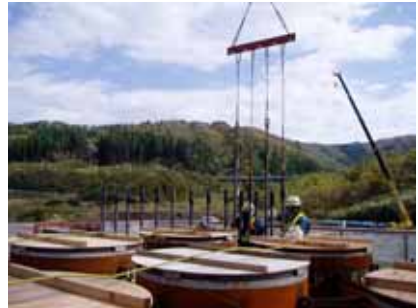
写真-4 主鉄筋建込み
