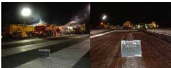
写真-1 切削状況
