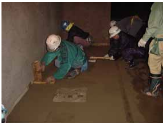
写真-2 端部転圧状況
