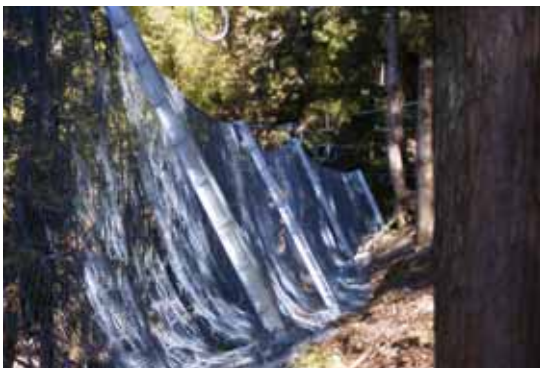
写真-1 リングネット施工現場
