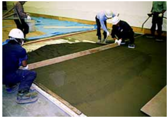
写真-4 摺り切り状況
