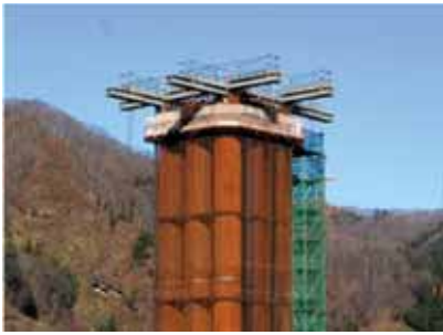
写真-6 反力架台
