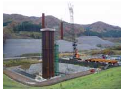
写真-5 鋼管建込み完了
