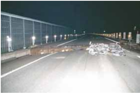
写真-3 第一段階における段差摺付状況
