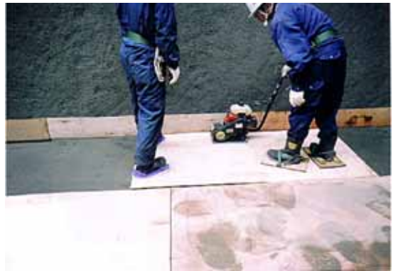
写真-5 転圧状況
