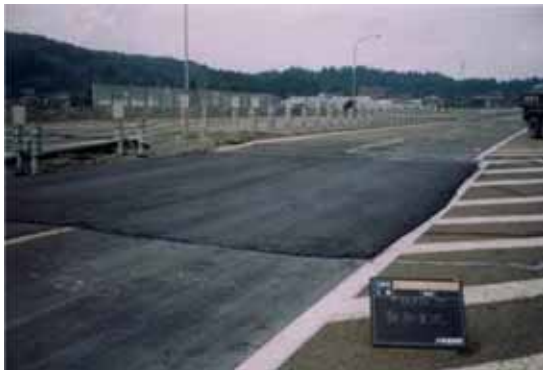
写真-4 第二段階における段差摺付状況
