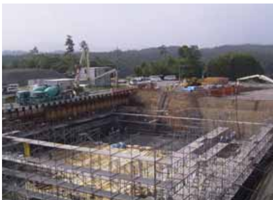
写真-3 コンクリート打設状況
