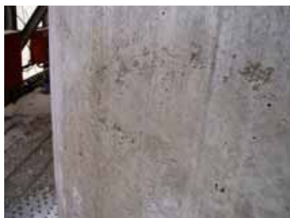
写真-11 躯体コンクリート剥離状況
