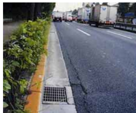
写真-1 導水管上のひび割れ (雑誌「舗装」2002.3月号より抜粋)
