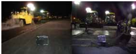
写真-3 舗装状況
