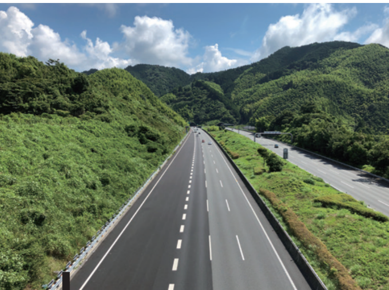
新東名高速道路 新清水IC~新静岡IC間6車線化工事 静岡県静岡市
