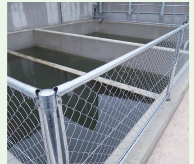
排水処理の仕組み(例: 大分センターアスコン敷地内の沈砂池)
