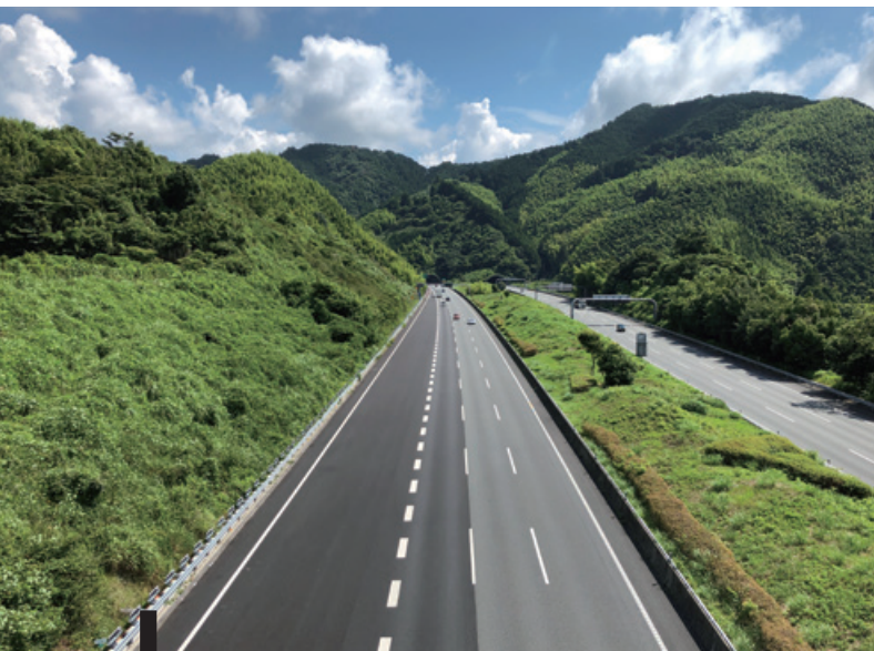
新東名高速道路 新清水IC~新静岡IC間6車線化工事 静岡県静岡市
