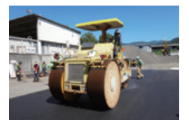
タフアスコンの施工
