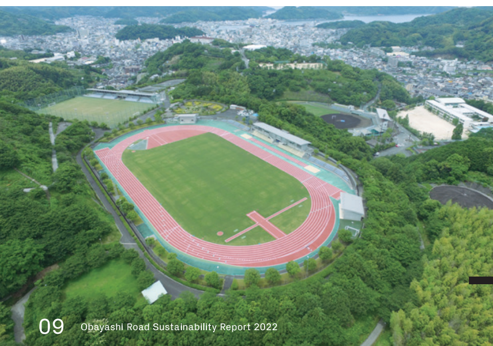
宇和島市丸山公園 陸上競技場改修工事 愛媛県宇和島市
