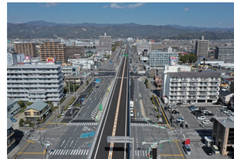
令和元-2年度 高須地区外舗装工事 高知県高知市
