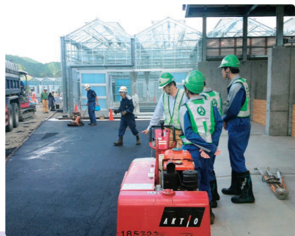
静岡営業所管轄工事にて
