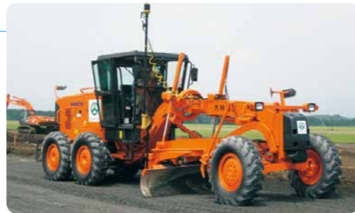
GNSSによる施工事例
