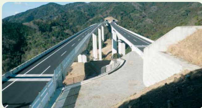
区間最長の日子橋全景
