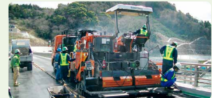
eグース施工状況
