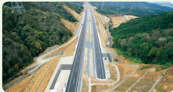
豊川市上長山地区 土工区間 (完成)
