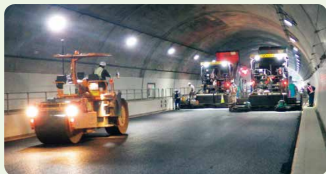
トンネル部の表層舗設状況
