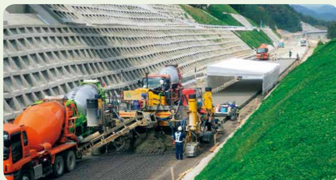
明かり部の CRCP 打設状況
