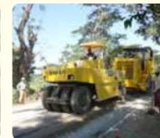
路上再生路盤工法 施工状況
