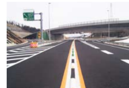
日沿道 村上IC舗装工事 (新潟県 2011年3月竣工)
