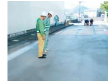
路面状態を目視で診断
