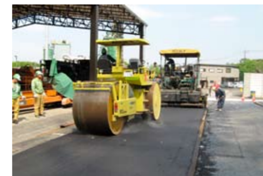
エコスムージーの試験施工
