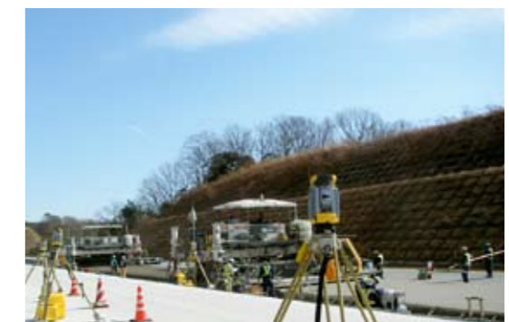
ICT を用いたコンクリート舗装の施工
