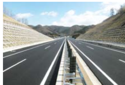
北関東自動車道 足利東舗装工事 (栃木県 2011年8月竣工)
