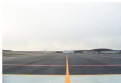
新千歳空港 誘導路舗装外一連工事 (北海道 2011年3月竣工)
