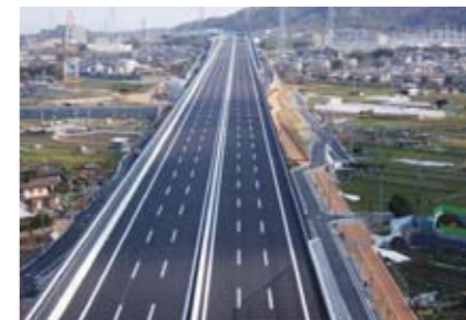
第二京阪道路交野舗装工事 (大阪府 2010年7月竣工)
