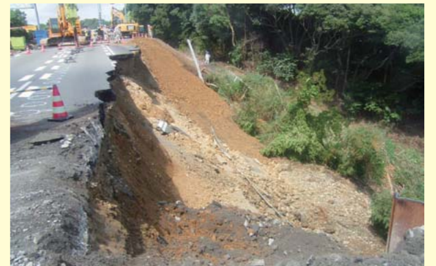
法面崩壊状況
