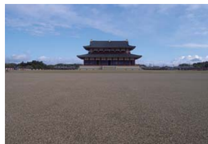
平城宮跡歴史公園第一次大極殿院広場 整備工事 (奈良県 2010年3月竣工)
