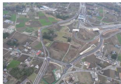
H21上尾道路桶川JCT内舗装工事 (埼玉県 2010年3月竣工)
