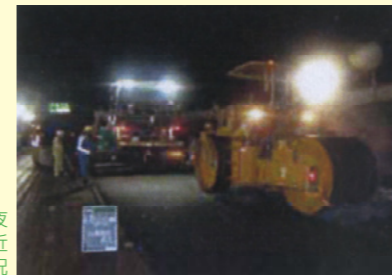
8月11日深夜 下り線 189.5KP 付近 舗装補修作業状況
