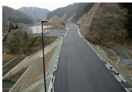
両石地区舗装工事 (岩手県 2010年3月竣工)
