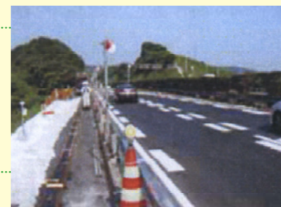
上り線 191.6KP 付近 通行止解除
