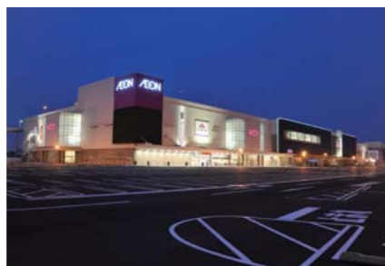
イオン土浦ショッピングセンター新築工事 (茨城県 2009年6月竣工)
