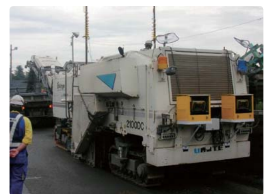
情報化施工機材を搭載した路面切削機の施工状況
