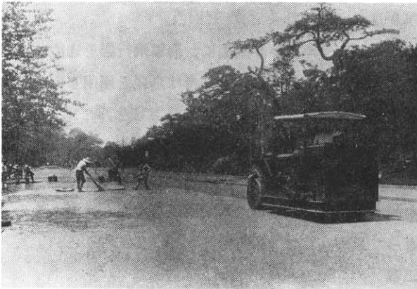
上野公園地内瀝青乳剤混合式舗装工事 (東京 昭9.6 竣工)
