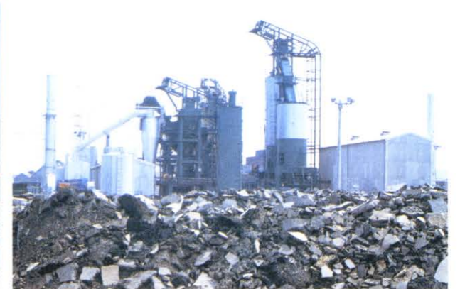
久喜アスファルト混合所
