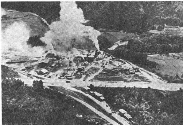
烏頭坂基地に設置したアスファルトプラント (100 t/h)
