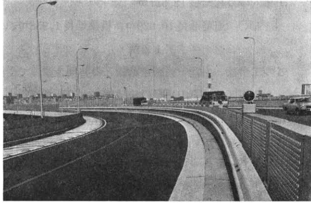
首都高速5号線（東京 昭51.11 竣工）
