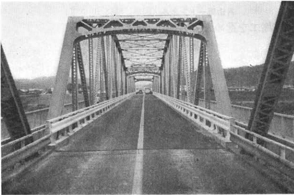
那賀川橋修繕（高知 昭56.3 竣工）
