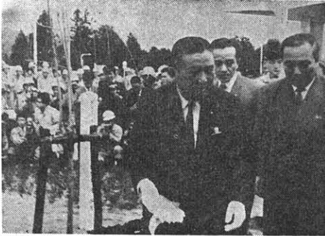
当社施工の関ヶ原インターチェンジで の河野一郎建設大臣の記念植樹の光景
