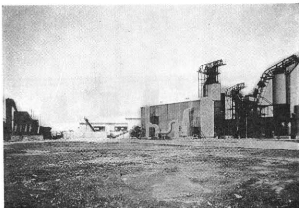
久喜アスファルト混合所（昭57.7 完成）
