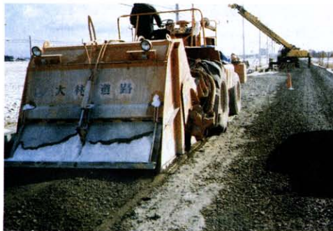
スタビライザーによる路盤再生
