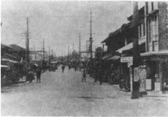
塩谷郡氏家町瀝青乳剤浸透式舗装工事 (栃木 昭9.3 竣工)
