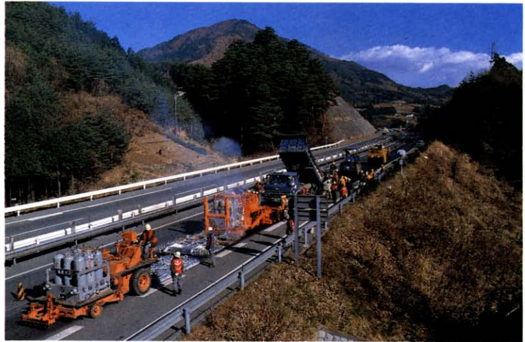
中央自動車道（大月付近）
