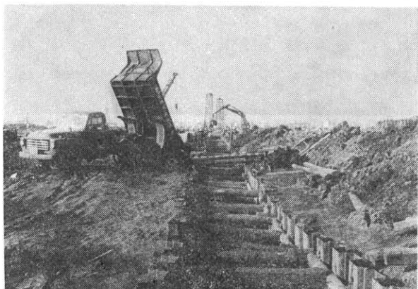
昭和42年度第1次13号地道路築造（東京 昭43.3 竣工）
