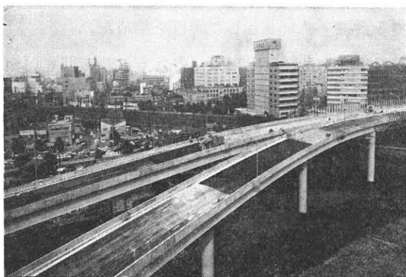
首都高速道路4号線・鎌倉橋付近（東京 昭39.7 竣工）
