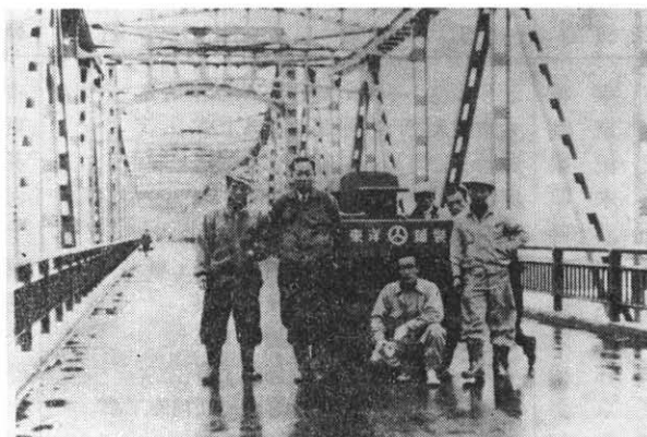
静岡県第三掛塚橋床版舗装工事（静岡 昭29.12 竣工）
