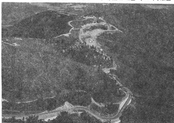
天理舗装（奈良 昭45.3 竣工）
