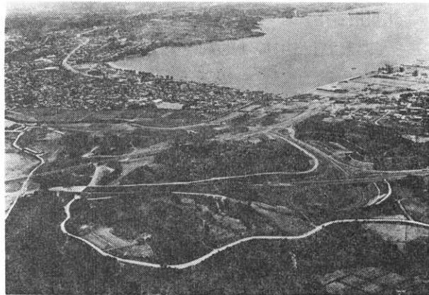
沖縄縦貫道石川（沖縄 昭50.5 竣工）
